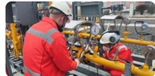
天信高压涡流量计应用传输管线
